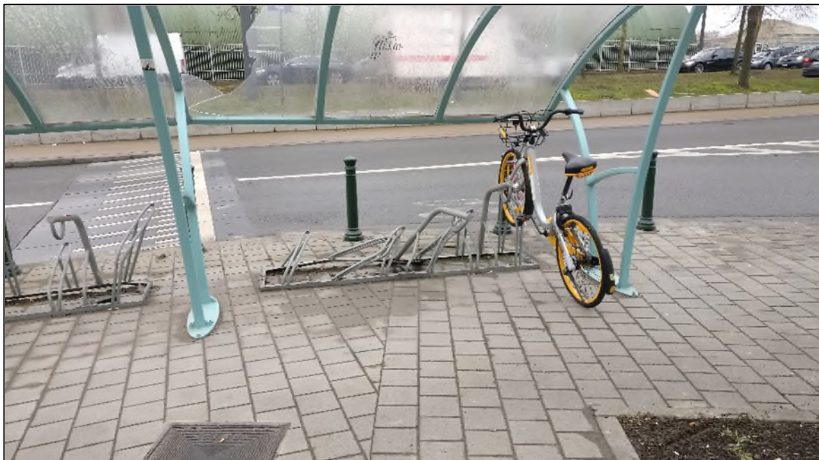
Figure 59 : Exemple d'installation dégradée (le vélo est un vélo en flotte libre « O Bike ») (Stratec, mars 2018)
